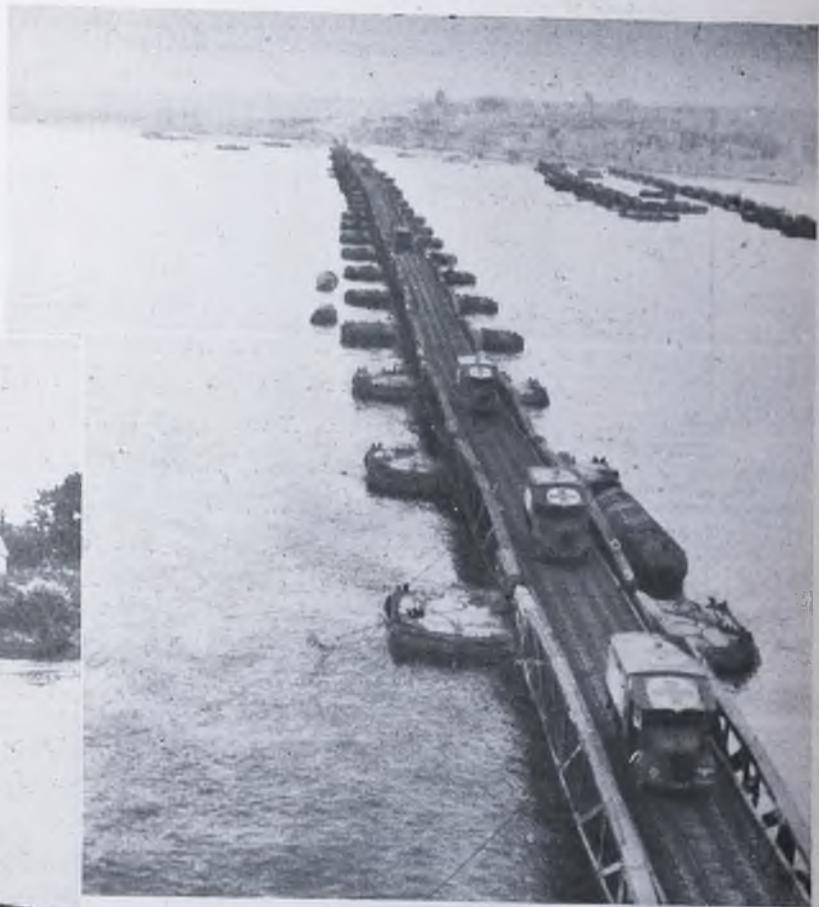
Puente flexible compuesto de docenas de pequeños tramos de acero, complemento de los muelles flotantes. Muelle y puente de construcción inglesa
