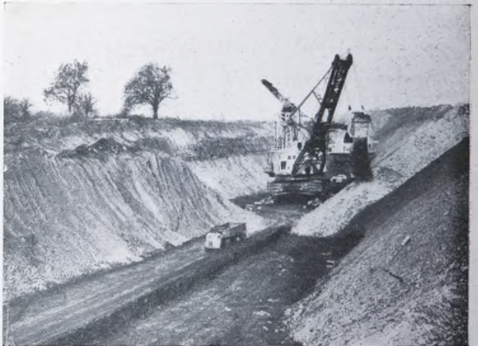
Una excavadora eléctrica trabaja en los Estados Unidos arrancando cuarenta toneladas de carbón en una sola vez. Compruébese su tamaño gigantesco comparándola con el camión
