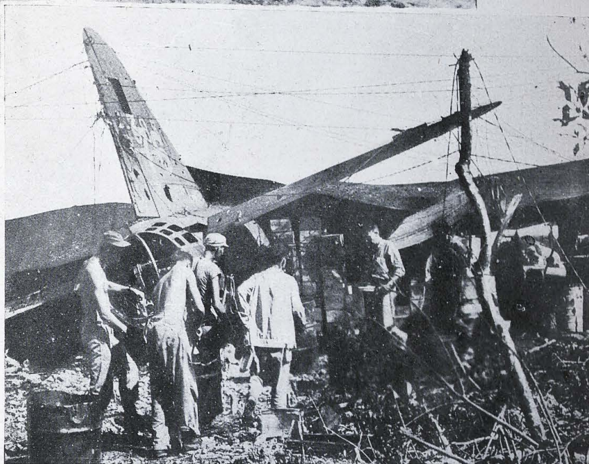
Soldados norteamericanos de Infantería de Marina, utilizando los restos de un avión japonés, a falta de postes, para el tendido de cables telefónicos
