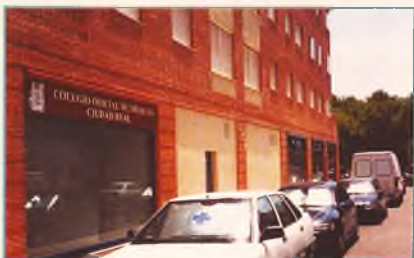
Fachada del Colegio de Médicos en la Avenida de los Institutos de Alcázar
