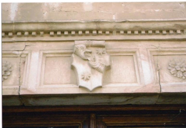
Figura 5. Dintel de la puerta principal del palacio Torremejía. Almagro
