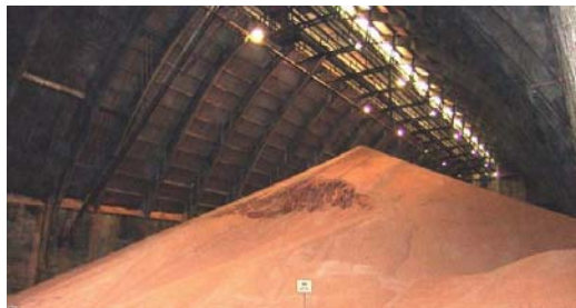
Silo de abonos nitrogenados. Puertollano
