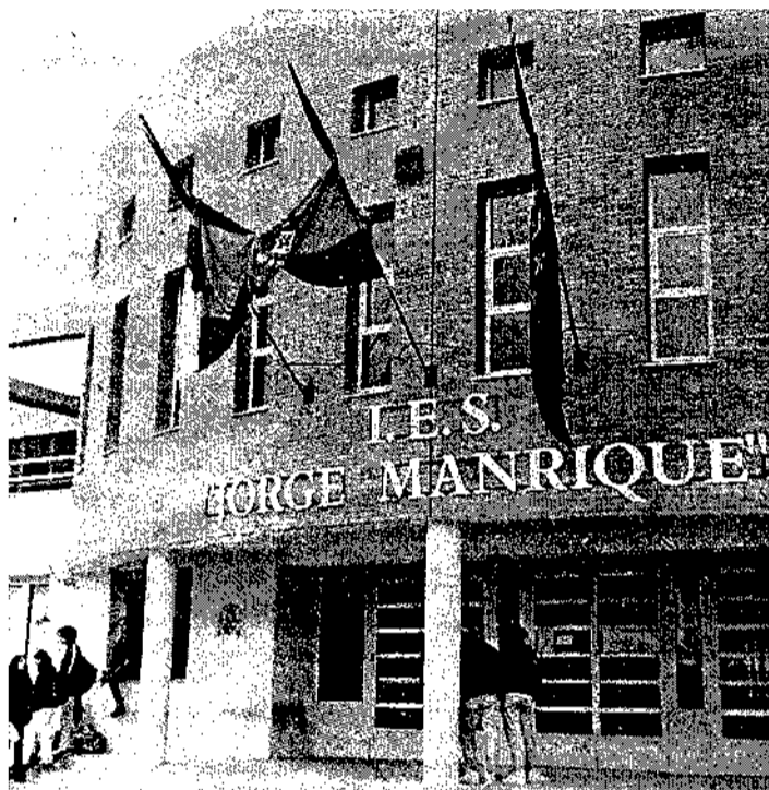
Fachada del instituto de Sisante.
