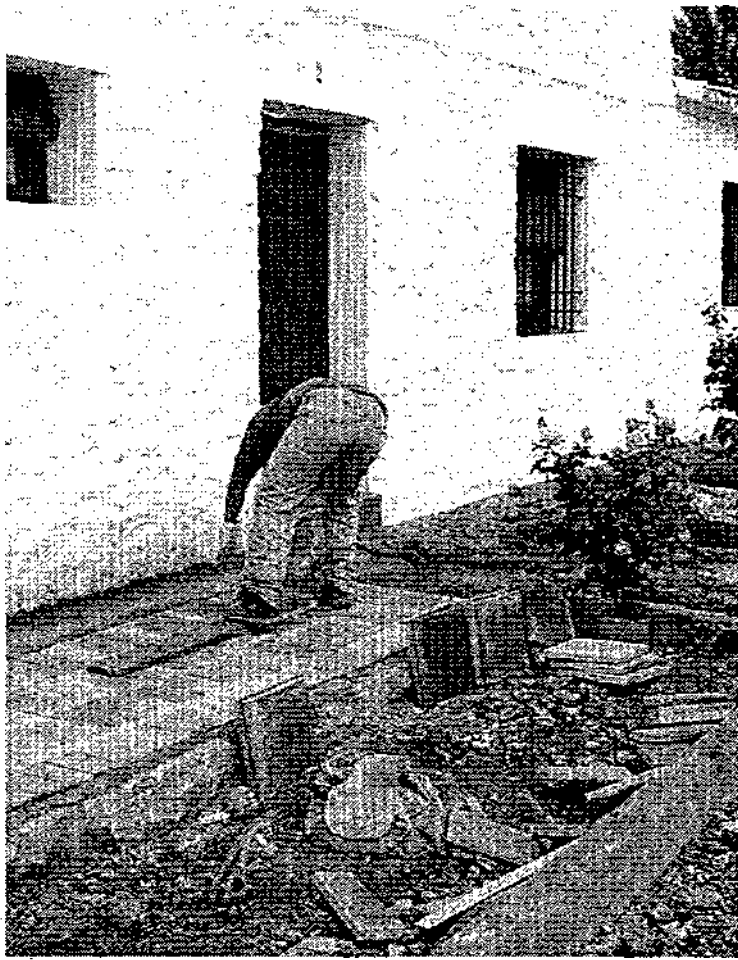
Las obras de pavimentación y acerado dan trabajo a tres personas
