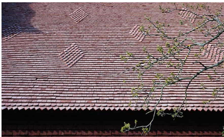
Faldón de cubierta. Establo. Suecia.
