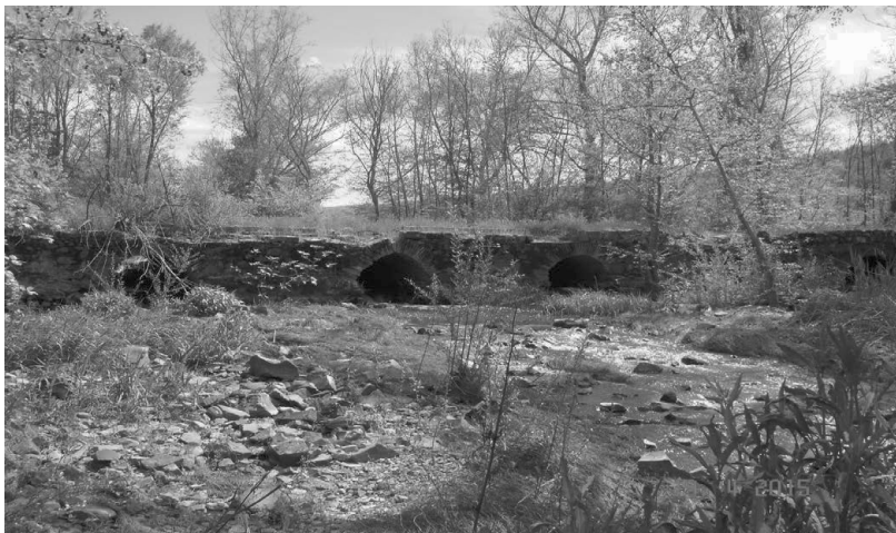
Figura 8. Puente del Molino de Valbuena. 2º tramo. Fotografía del autor.
