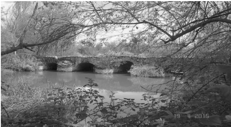
Figura 7. Puente del Molino de Valbuena. 1er tramo. Fotografía del autor.
