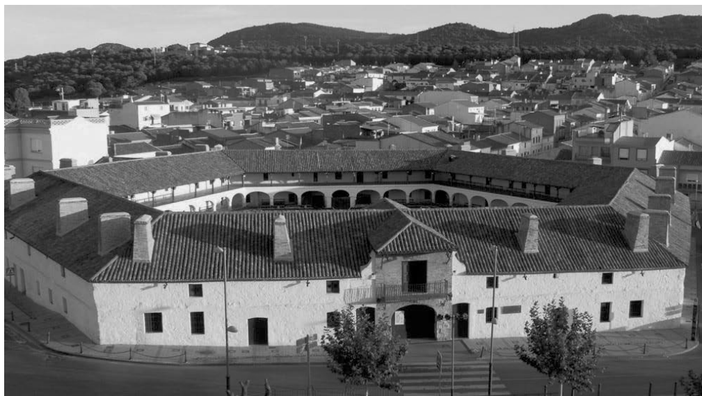
Figura 9. Vista aérea plaza de toros.
