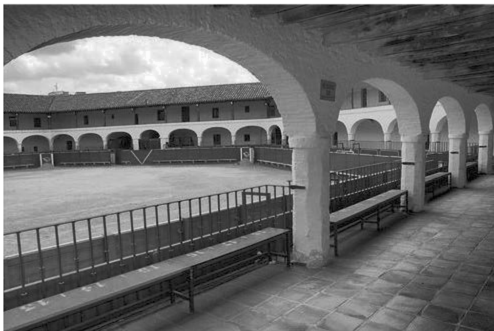
Figura 10. Vista galería inferior plaza de toros
