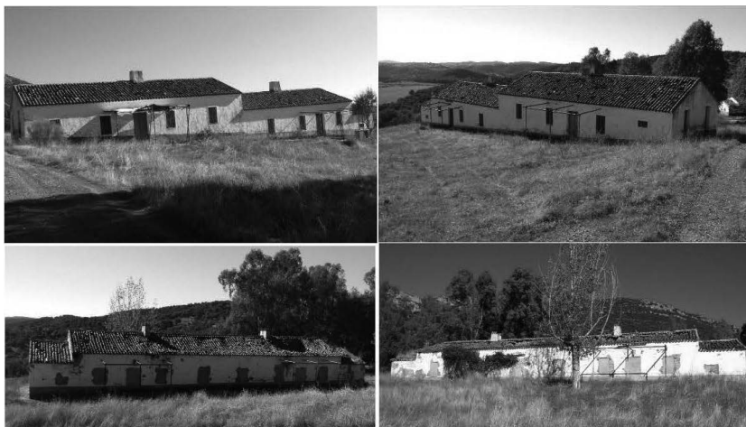
Figura 8: Estado actual viviendas construidas en 1925. Elaboración Propia.
