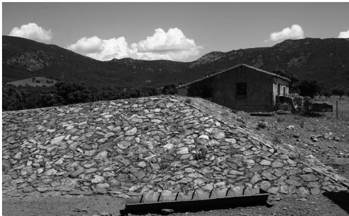
Figura 6: Cubierta del búnker principal.
