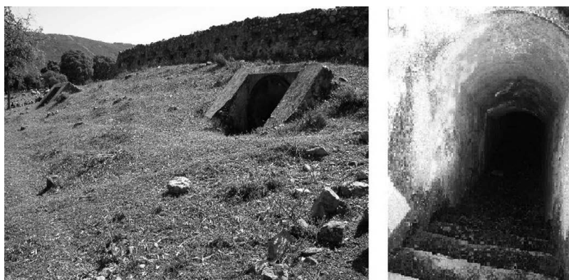
Figura 4: Entradas al búnker principal.
