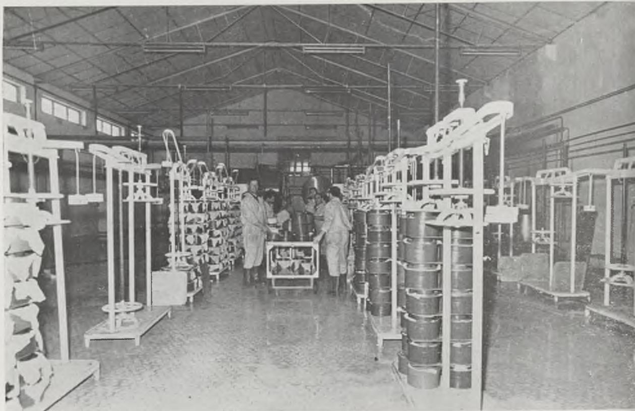
La "foto" no nos muestra uno de los complicados dispositivos para el seguimiento de satélites espaciales, sino una vista parcial de la nave de prensado. Una vez metido el cuajo en sus moldes, estos son prensados hasta extraerles todo el líquido que queda. Las "colgaduras" que se aprecian alrededor de los moldes, son paños blancos y nítidos, en los que se envuelve la cuajada. limpieza y asepsia por todas partes.
