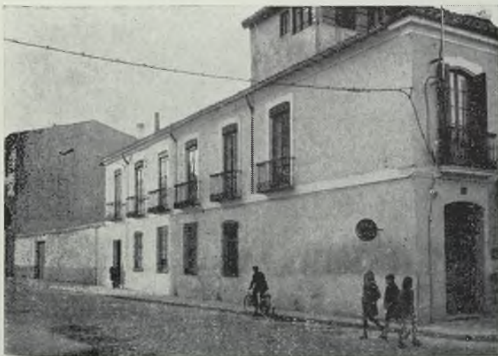
Otro aspecto de la casa que va a ser alineada, por esta parte seguirá la línea que marca la fachada del Gobierno Civil
