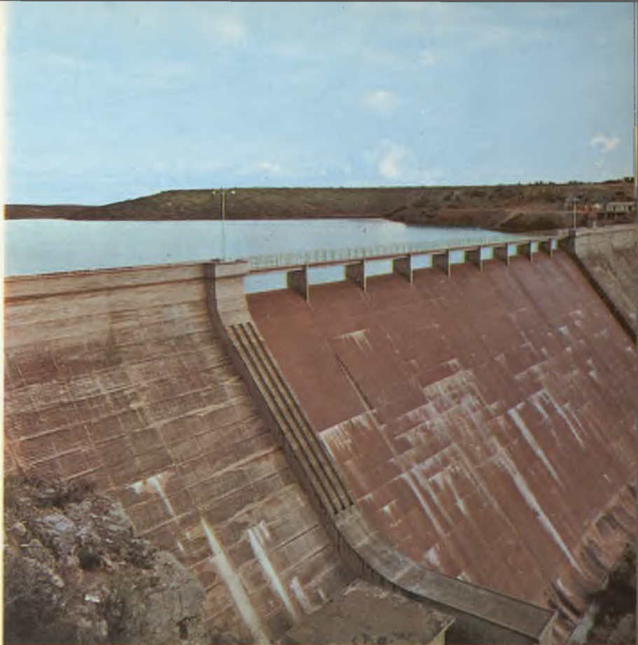
Presa de Peñaarroya, una de las que forman el gran complejo hidroeléctrico del Guadiana.
