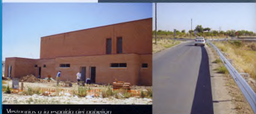
Vestuarios a la espalda del pabellón
