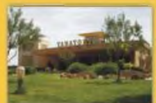
Zona Ajardinada Amplios Aparcamientos
