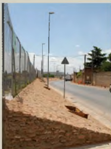
Talud en la entrada desde Valdepeñas
