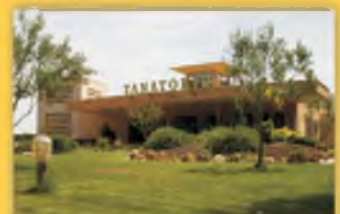
Zona Ajardinada Amplios Aparcamientos
