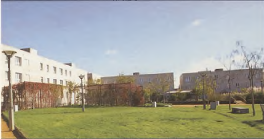
Vista de los inmuebles desde el parque de El Alto
