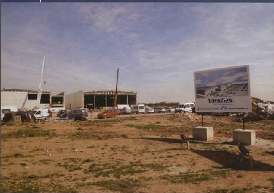
Estado actual de las obras
