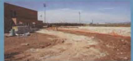
Cimentación de las pistas. Se construyen detrás de la ampliación del Pabellón
