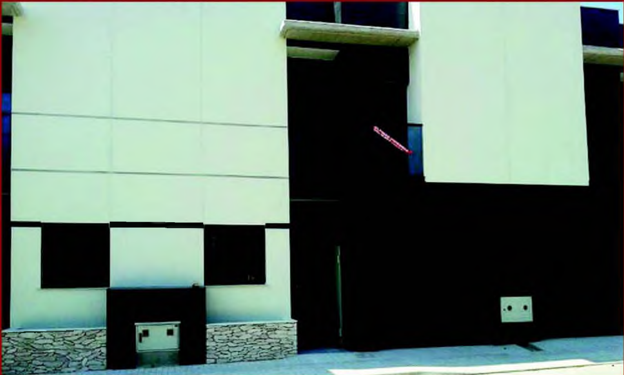
Detalle de fachada principal
