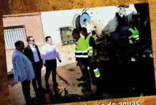
Limpieza del emisario de aguas
