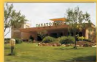
Zona Ajardinada Amplios Aparcamientos
