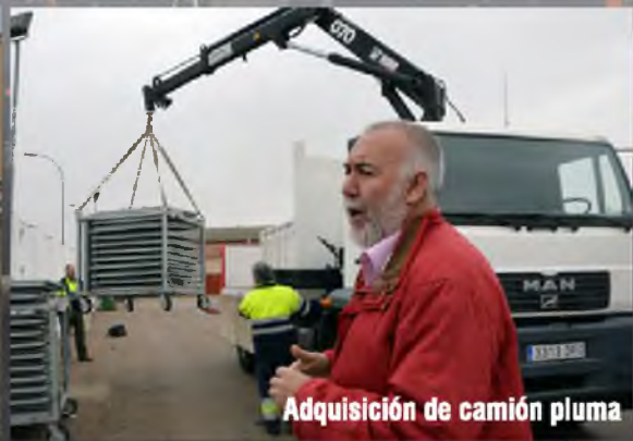
Acondicionamiento Vía Pública
