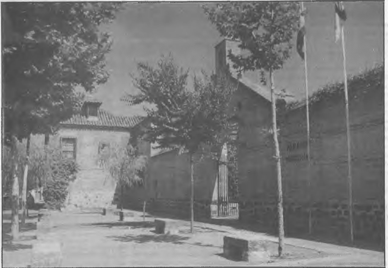
Fachada principal del Parador Nacional de Turismo
