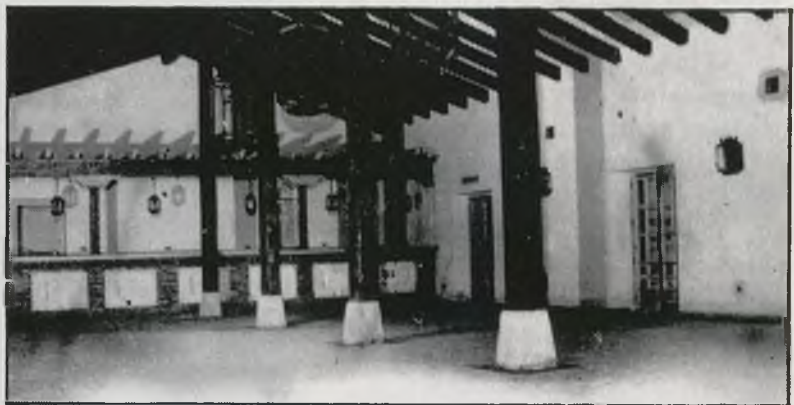
Vista parcial del salón y bar del hotel municipal.
