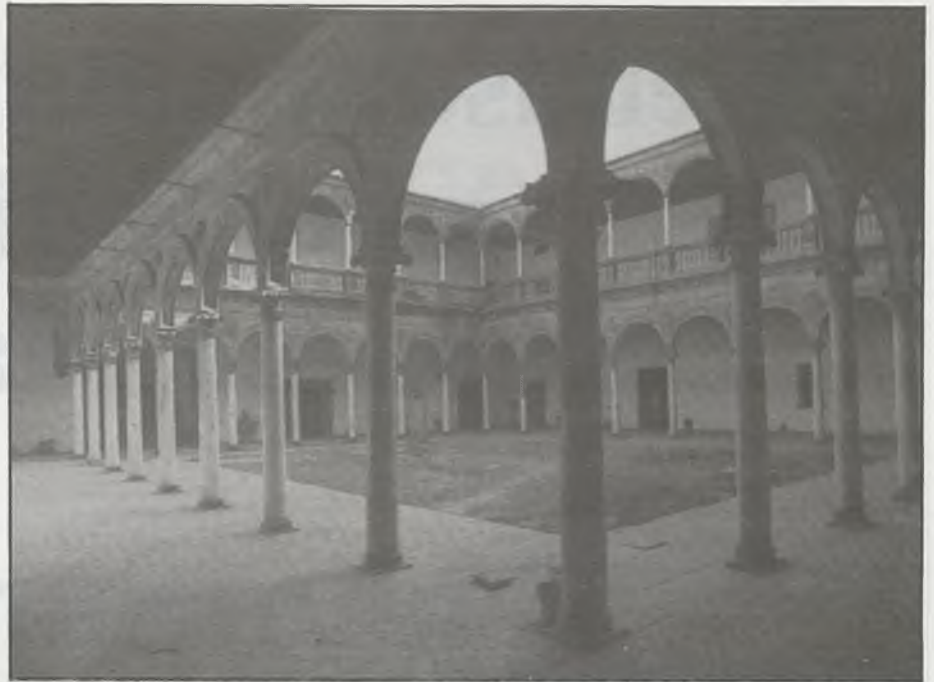
Detalle del Claustro del Convento de la Asunción de Calatrava.
