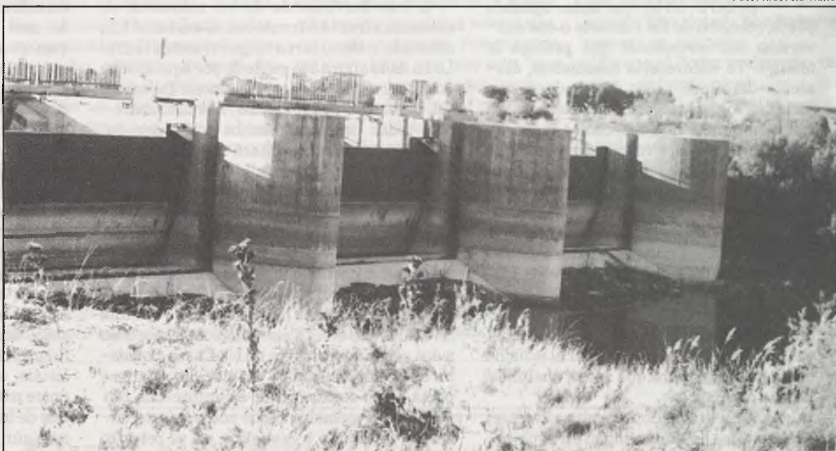
Presa de "Puente Navarro" de reciente construcción (1985), situada en la zona Sur del parque en "restauración". Retiene aguas estancadas desde su construcción, que este año por primera vez serán evacuadas y renovadas.
