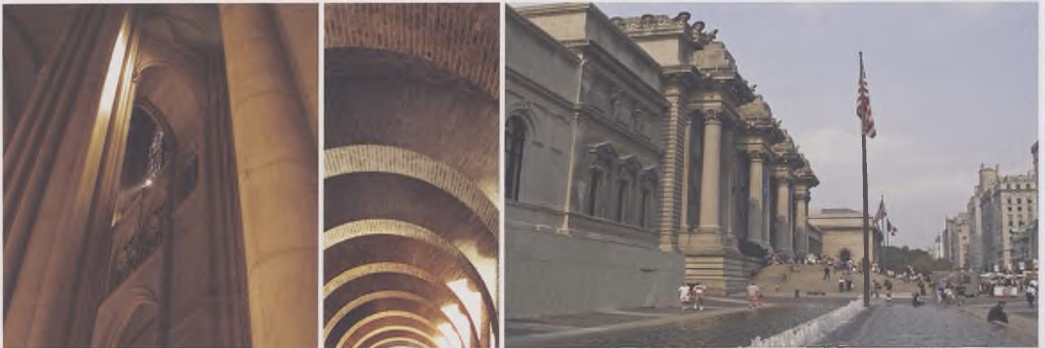
12 Un templo para la tolerancia. La Catedral de St. John the Divine, de Heins&LaFarge y Cram&Ferguson, desde 1899 (septiembre 2003, Mar Loren / Jacques Maes) 13 El poder del dinero. La presencia urbana de la arquitectura bancaria y corporativa. El pórtico del Barclay Vesey Bank, de Ralph Walker de McKenzie, Voorhees y Gmelin, 1927 (septiembre 2003, Mar Loren / Jacques Maes) 14 La presencia urbana reclamada por la cultura. La fachada del ala diseñada por Richard Morris Hunt, Museum Mile (septiembre 2003, Mar Loren / Jacques Maes)
