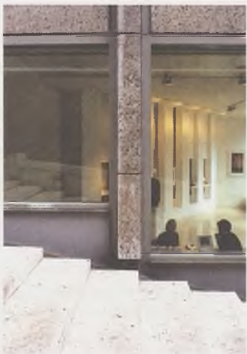
38 The Economist Building. Detalle de las escaleras de subida a la plataforma. Fotografía del autor
