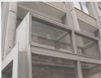
36 The Economist Building. Lucernarios sobre las estancias situadas bajo el nivel de Bury Street, la calle posterior. Fotografías del autor
