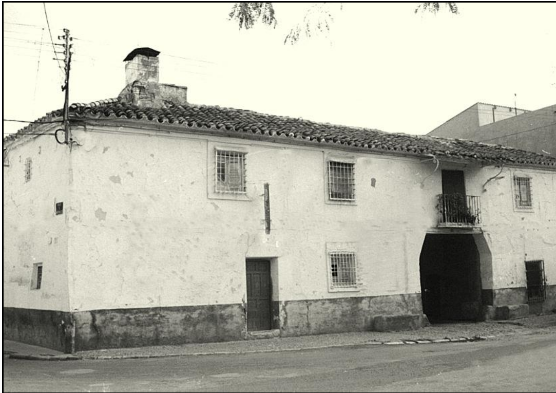
Posada de Casto González Mora en Fachada del Río
