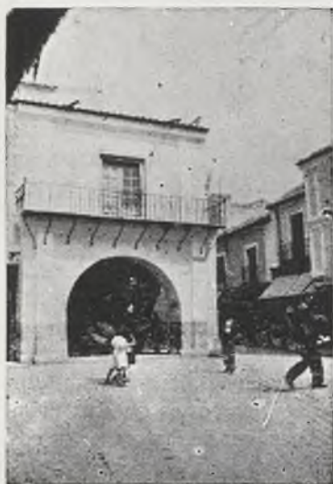
La antigua Casa del Ayuntamiento, construida sobre la tienda que le fué confiscada al judaizante Alvar Díaz.
