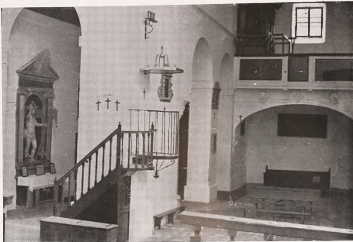
Vista de la nave principal, y de una lateral y coro de la Iglesia de San Miguel, reconstruida. Octubre 1952.
