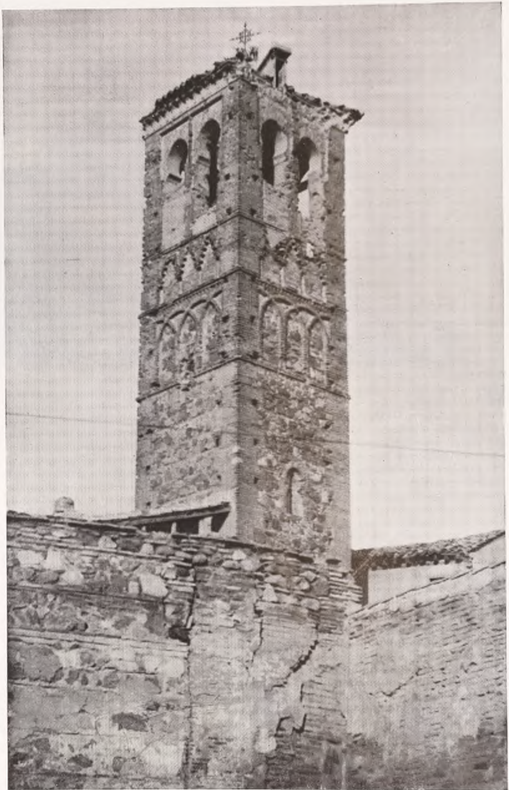
Estado de la torre de la Iglesia de San Miguel, en diciembre de 1951, antes de iniciarse las obras de reconstrucción.
