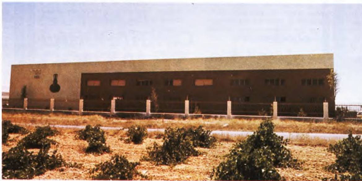
Vista exterior de nuestras instalaciones.
