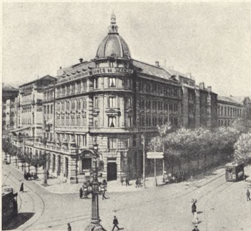
EDIFICIO DE SU PROPIEDAD EN BILBAO
