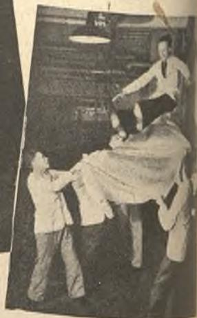
Los técnicos han transformado el vidrio en producto textil. Con vidrio se ha confeccionado tejidos de resistencia notable. Vemos en esta fotografía un singular experimento, en un establecimiento donde se fabrica «lana de vidrio»: prueba a cuenta de la resistencia de un tejido de vidrio.
