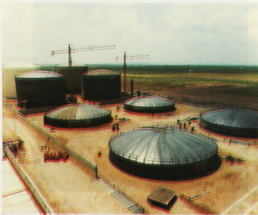
Depósitos de 5.000.000 de litros para productos inflamables.
