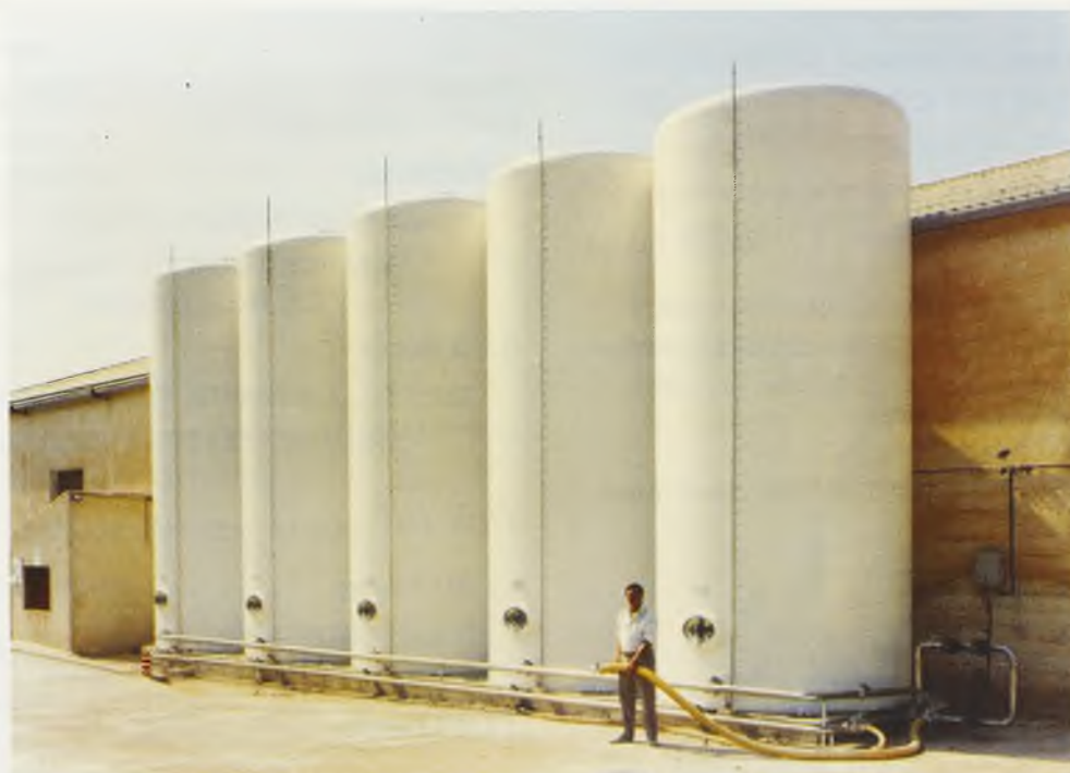
Batería de depósitos para recepción y distribución de abonos líquidos, con capacidad de 50.000 litros Ø 3 metros
