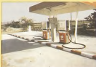
Instalaciones para consumo propio
