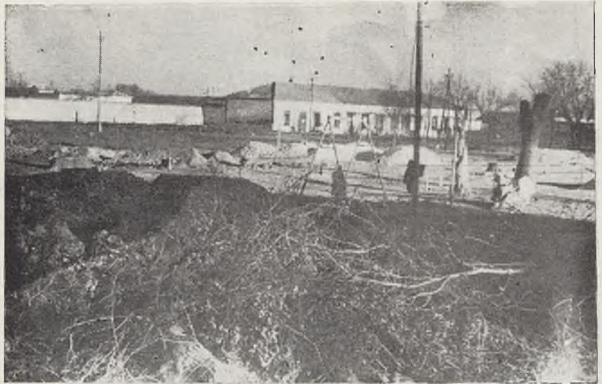
Estado de las obras que se realizan en la antigua Granja Agrícola para el nuevo Instituto de Enseñanza Media, cuyo coste será de
