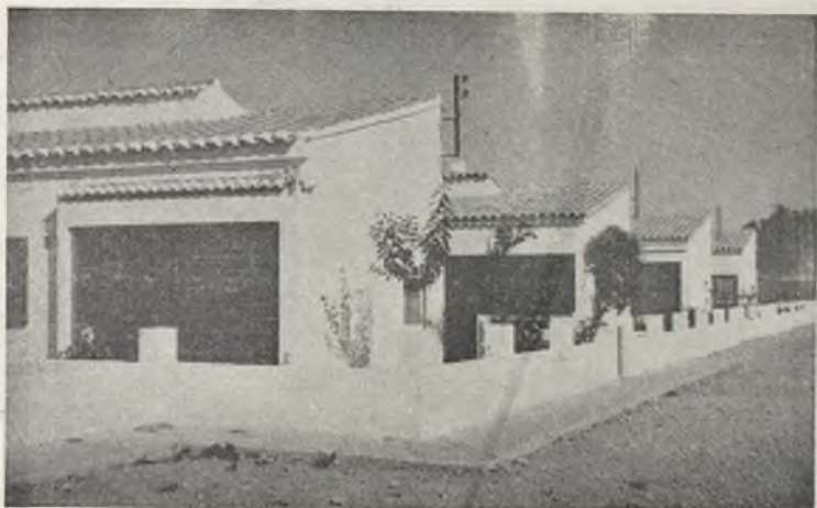
Otro aspecto de los chalets del Carmen
