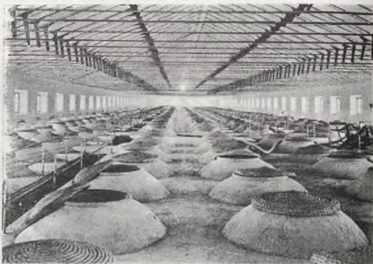
Una de las inmensas naves de la sección de vinos
