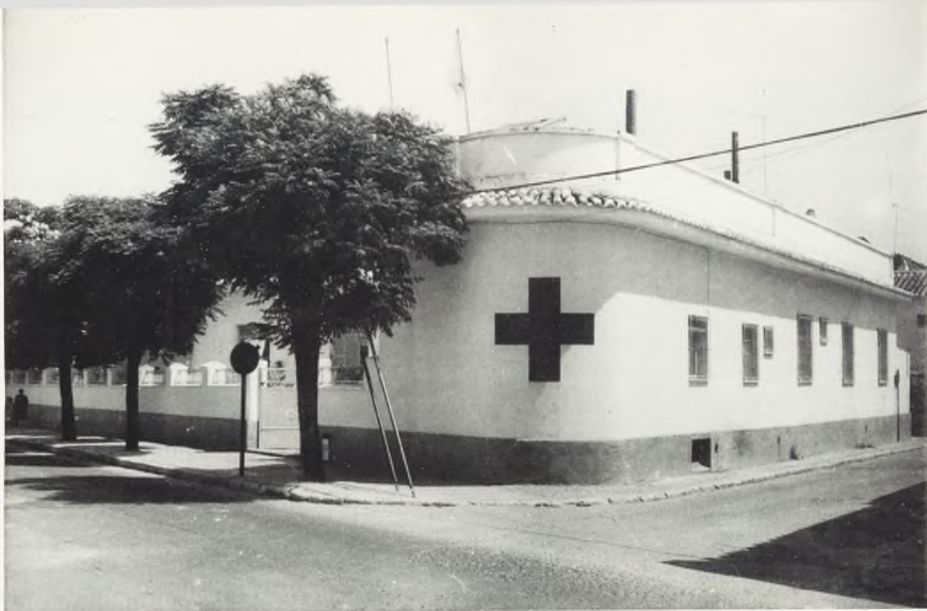
Edificio de propiedad municipal, que fué cedido en uso a la Cruz Roja Española, Asamblea Local de Daimiel, por acuerdo del Ayuntamiento pleno de fecha 17-9-82 en el que la Benemérita Institución viene prestando un importante servicio humanitario, digno de todo elogio.
