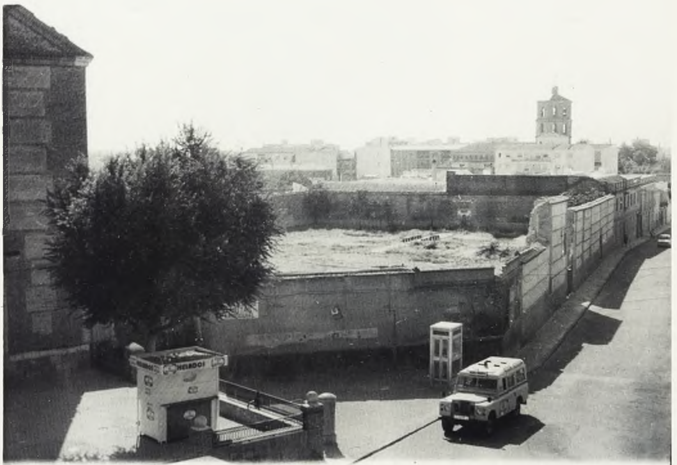
Solar de 4.000 metros cuadrados en la calle Jesús, adquirido por el Ayuntamiento para la construcción de la estación de autobuses y la posible construcción de un pabellón polideportivo cubierto.
