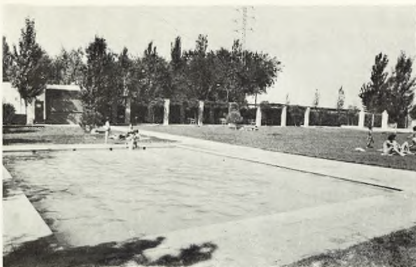
Piscina infantil y Terraza, construídas en el recinto de la Piscina Municipal, que han supuesto un importante complemento de la misma.
