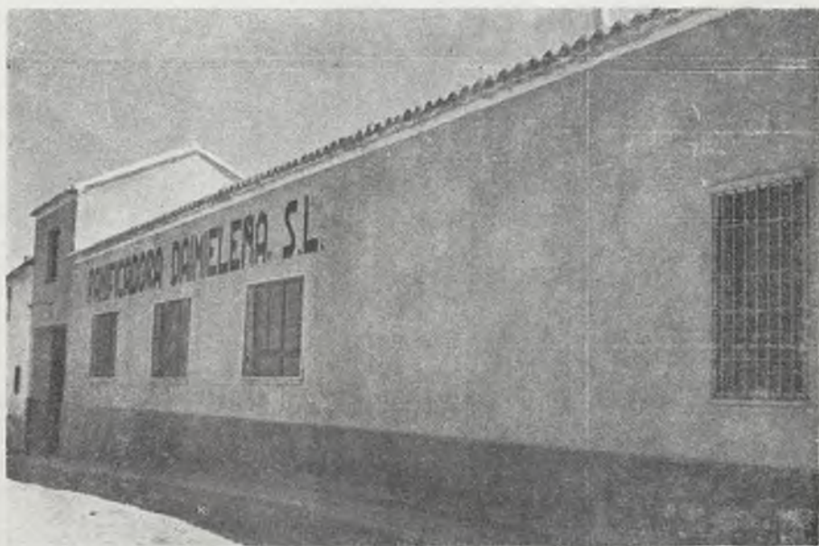
Vista parcial del edificio
