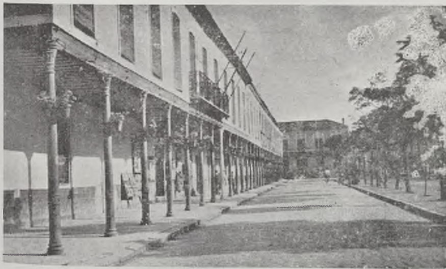
Esta ya nuestra antigua plaza nos demuestra el recuerdo de un pasado; los macizos y losetas de la actualidad taponan la existencia de estos árboles carcomidos.
