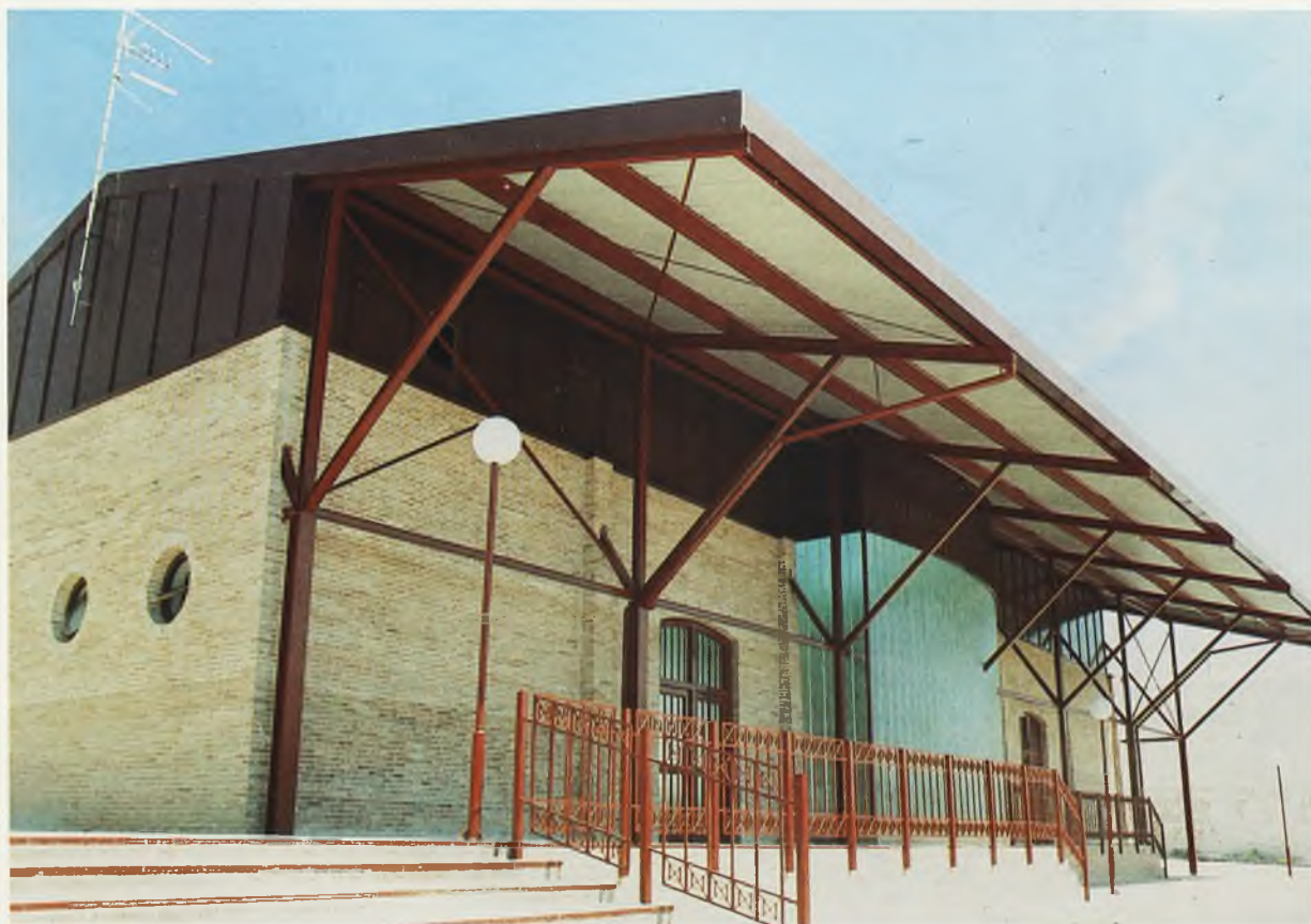
Estación de Autobuses construida en la Plaza de Toros proxicamente será inaugurada y puesta en servicio.
