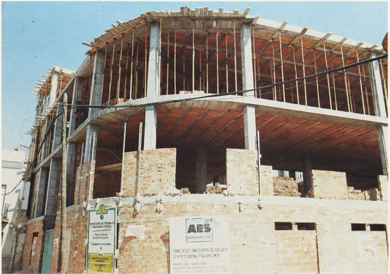
Edificio en Construcción para Centro de Salud y Centro Social Polivalente (Hogar del Pensionista).
