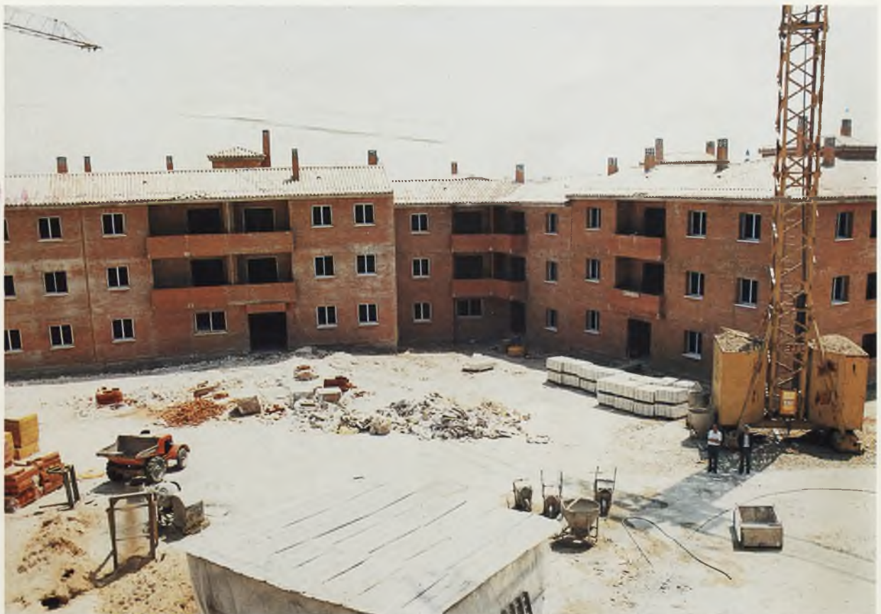
Estado en que se encuentran las obras de construcción de 132 Viviendas de Promoción Pública y ubicadas en el solar del antiguo "Lavadero", que se terminarán en los próximos meses.
