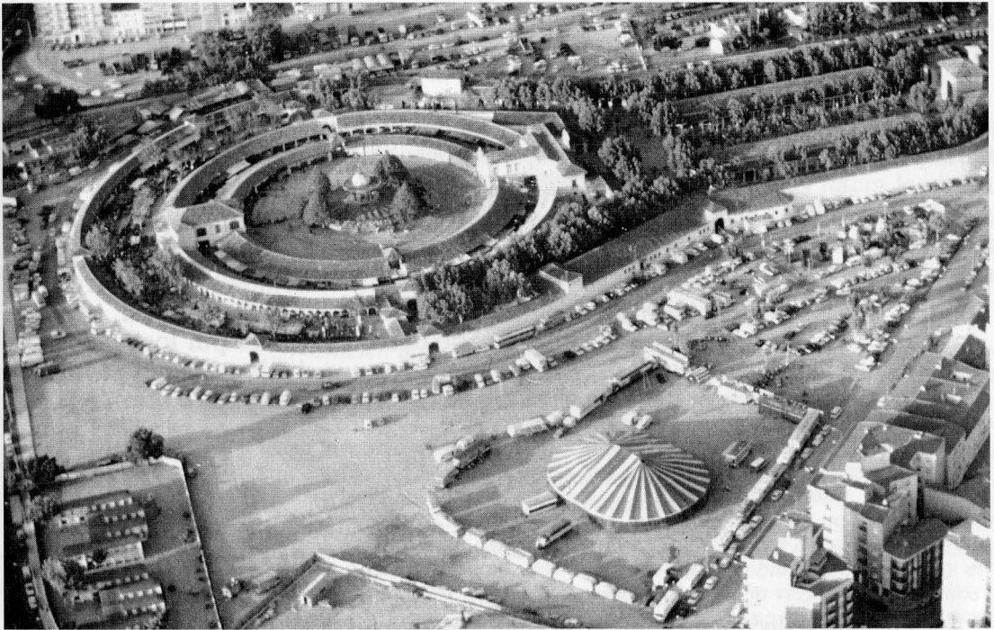
En nuestros días, el edificio ferial, aunque ampliado, conserva la estructura que tenía en el siglo XVIII. Fotografía captada por JUAN GARRIDO SEVILLA.
