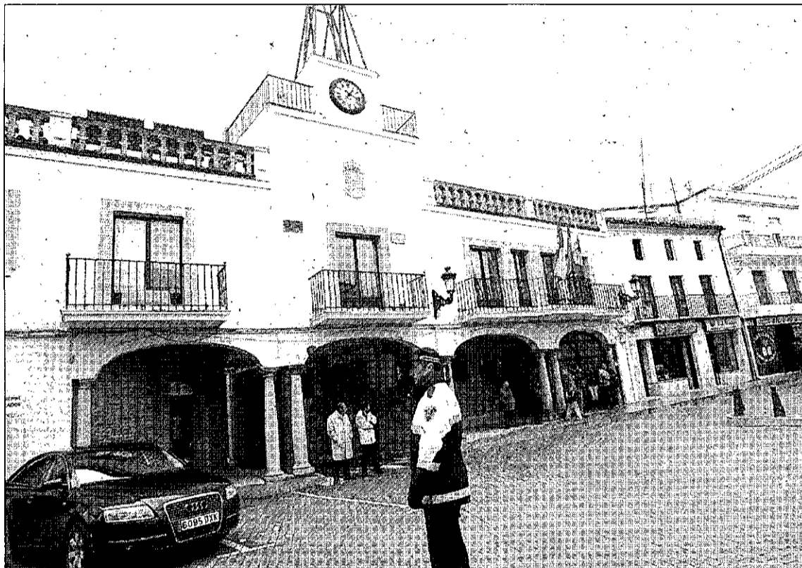
Fachada del Ayuntamiento de Almadén. / LT
