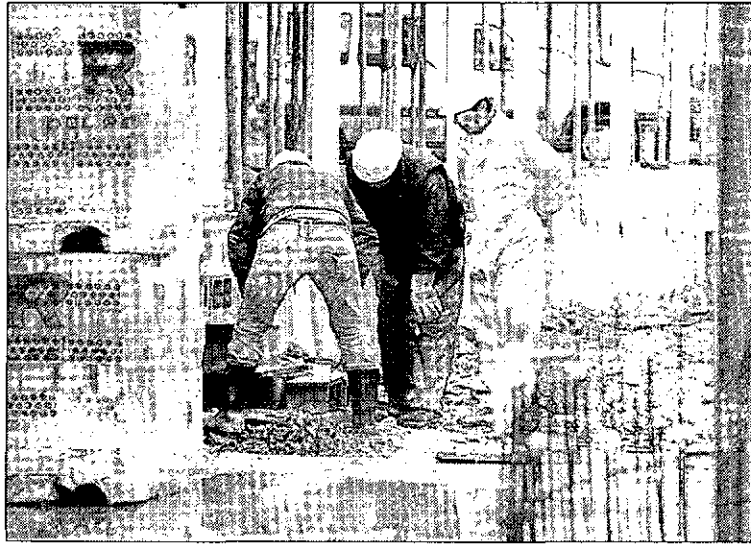
Empleados de la construcción trabajan en unas obras de una vivienda. / RUEDA
