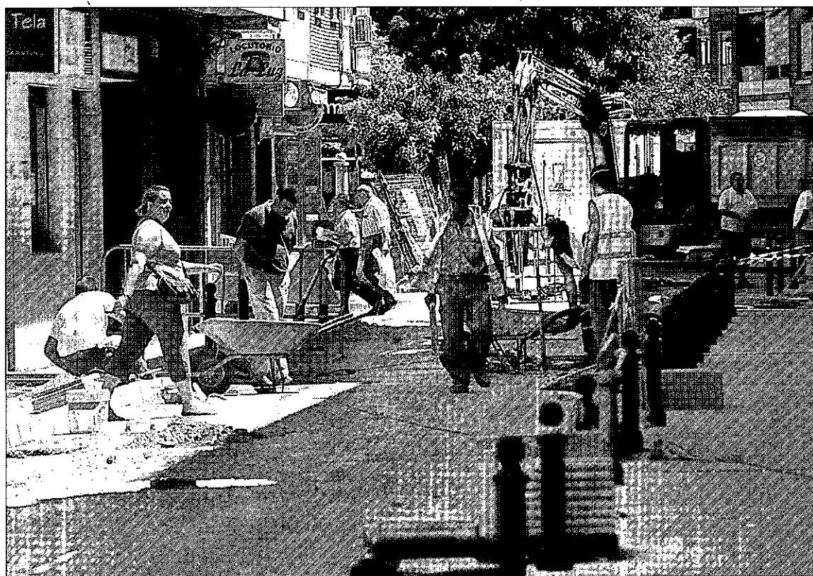
La calle Jacinto, que ya estuvo en obras este verano y hoy se corta al tráfico, está incluida dentro del Plan E. / TOMÁS FERNÁNDEZ
