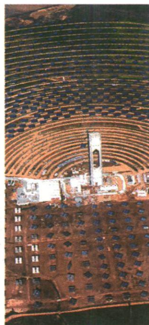
Planta fotovoltaica. AN
