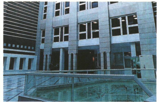
Detalle del edificio Albareda, vendido por Reyal Urbis. AN
