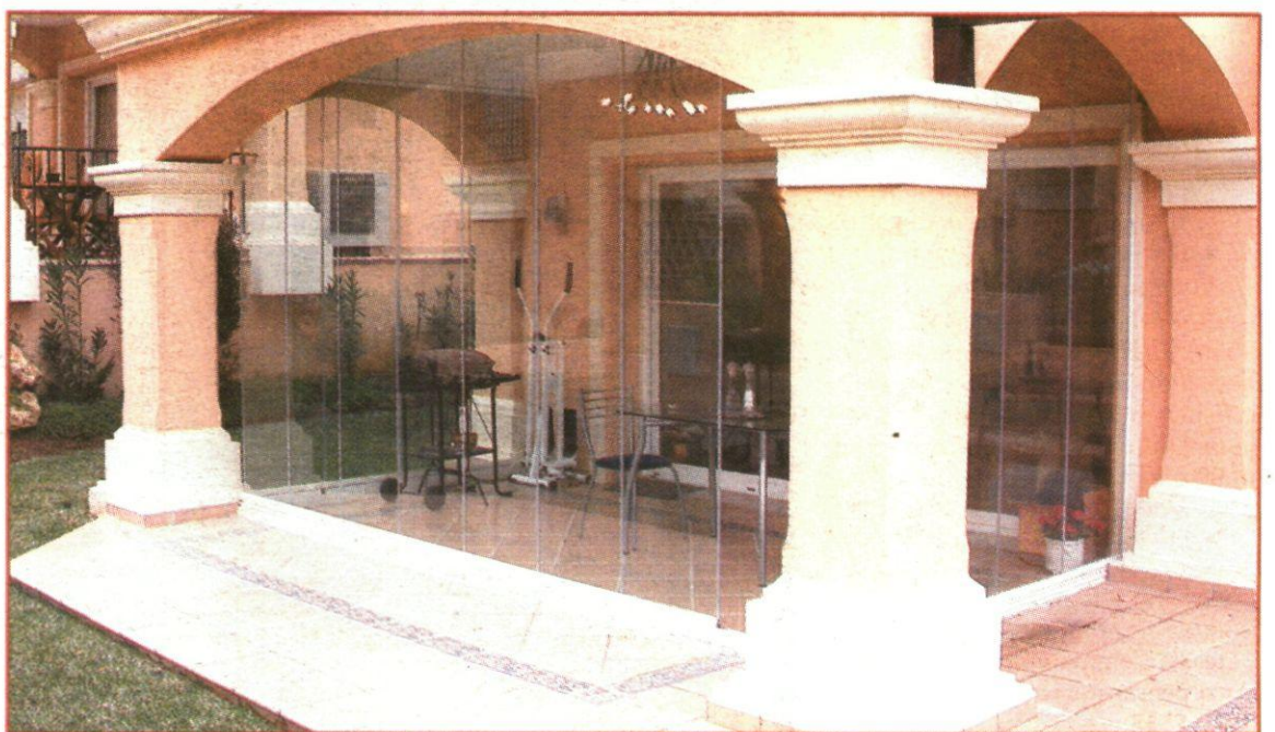
Este tipo de cerramiento reduce el ruido y los gastos en calefacción. / LT
