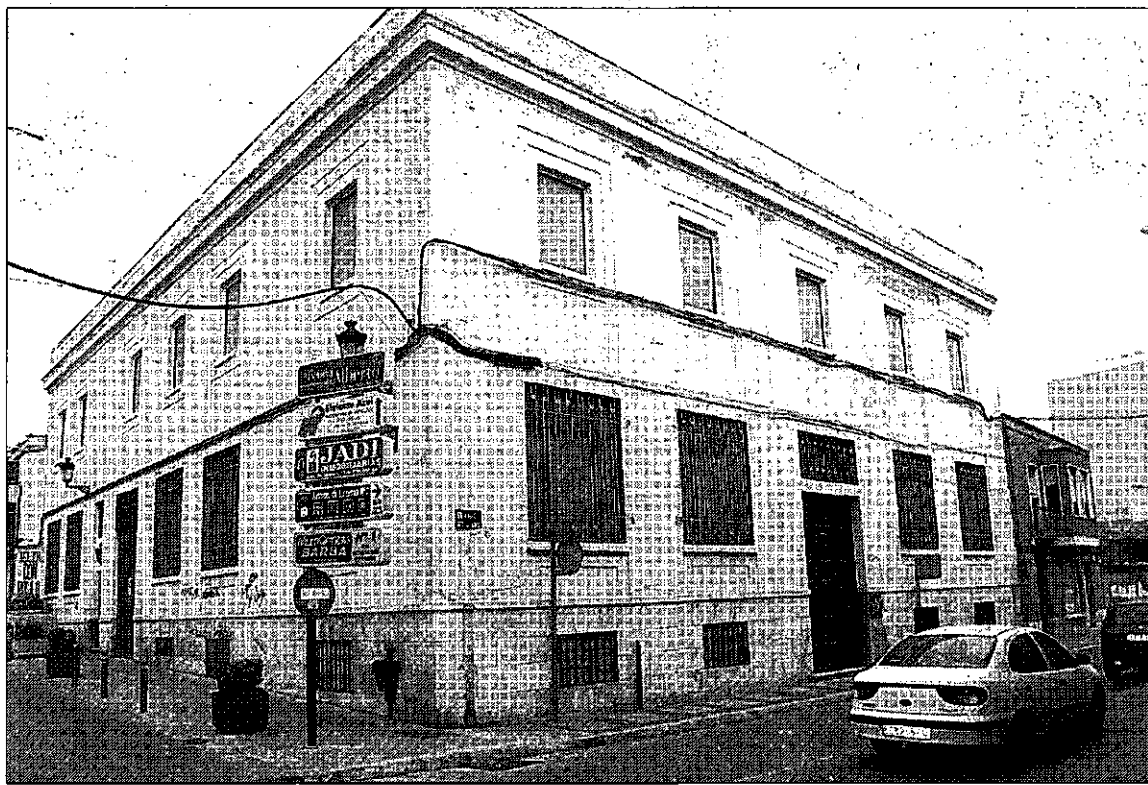
Fachada del edificio de Correos de Valdepeñas en la calle 6 de junio, que será derribado para construir la nueva plaza. / LT
