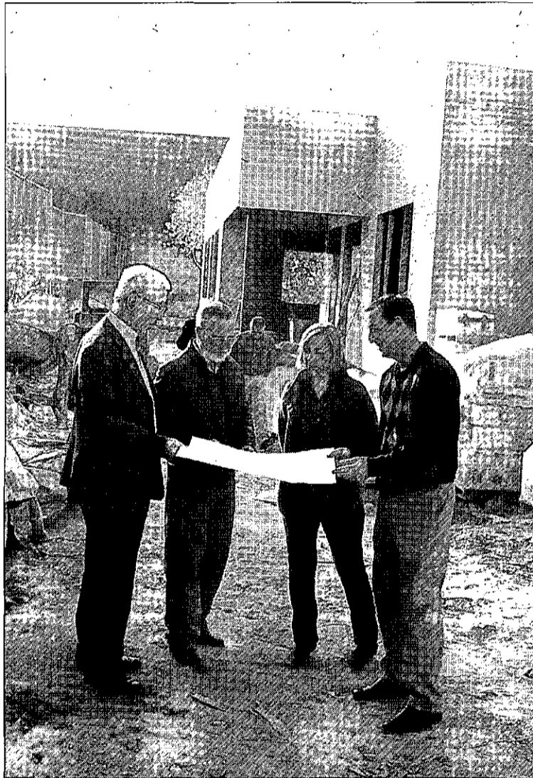
Rivero y Valle Fuentes, en la visita a las obras del comedor del Pérez Galdós. / LT
